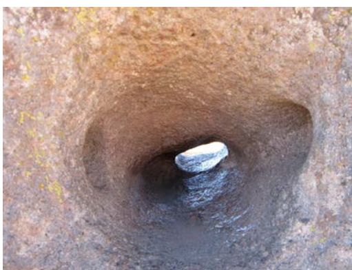
Figura 65. Orificio en el muro norte del Sanctasanctórum
